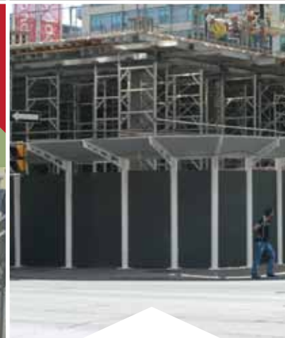
RT2 Passages piétonniers couverts
